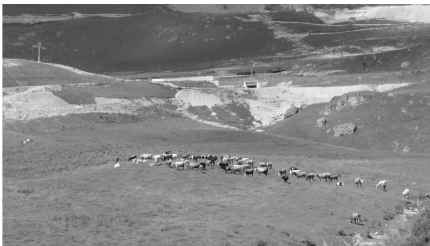
Рис. 1. Летнее пастбище и последствия строительных работ в альпийской зоне Большого Кавказа (Шахдаг-Гызылгаинский массив, 2016)
