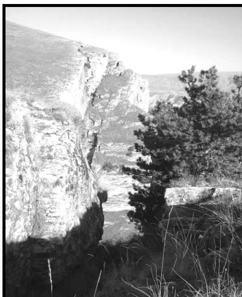
Рис. 5. Трещины бортового отпора и сколотые блоки. Левый борт Акушинского каньона.
