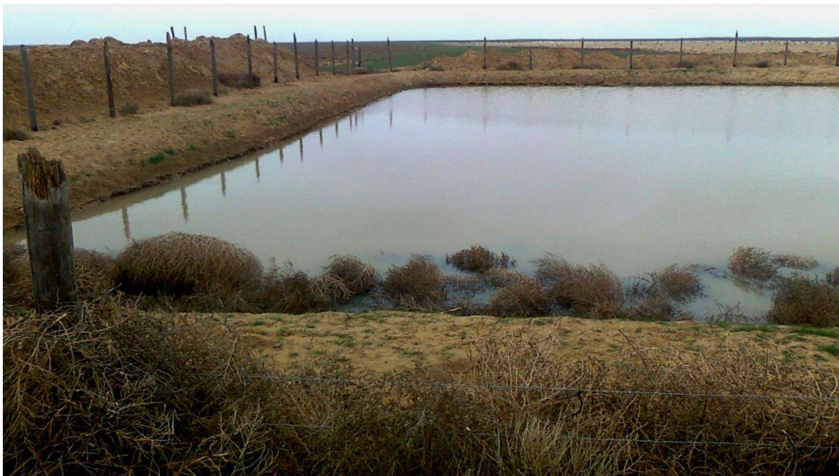
Рис. 2. Накопитель пресной подземной воды, поступающей самотеком из скважины на территории КБС
