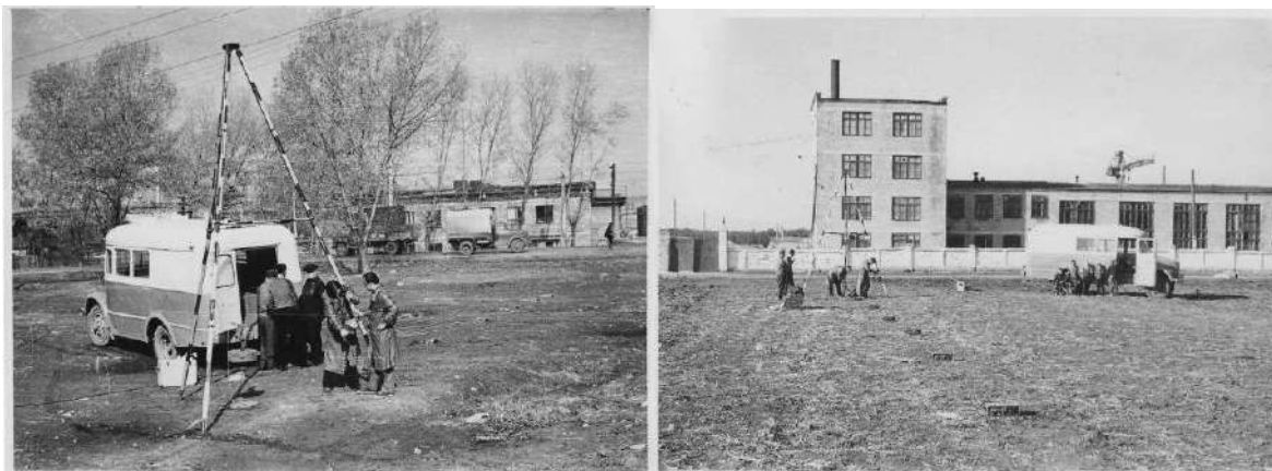
Рис. 1. Проведение работ по сейсмическому микрорайонированию г. Орджоникидзе (Владикавказа) сотрудниками ИСМИС, 1970 г.
