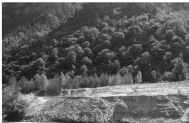
Рис. 3. Процесс размывания рекой Кубань отстойного хвостохранилища Эльбрусского ГОКа. В основании отвалов хорошо видны отходы горно-рудных масс, верхняя часть сложена отходами переработки руд.
